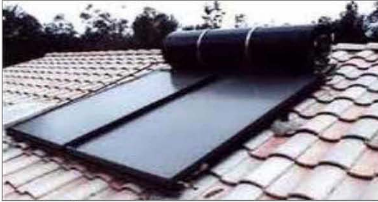
Εικόνα 10: Ηλιακός θερμοσίφωνας σε ταράτσα
