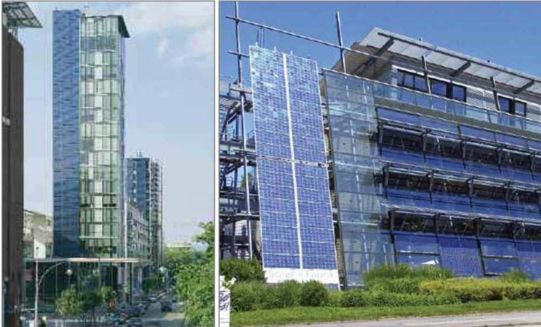
Εικόνα 11 : Φωτοβολταϊκά συστήματα σε κτίρια
