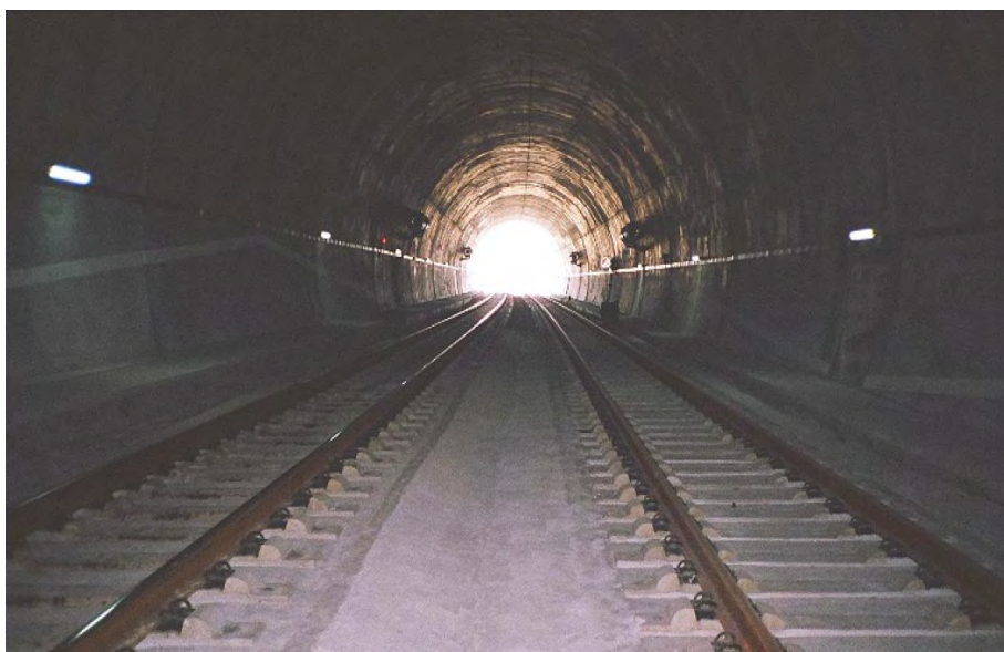
Εικόνα 3: Η πρώτη Σταθερή Επιδομή στην Ελλάδα στη σήραγγα Τεμπών
