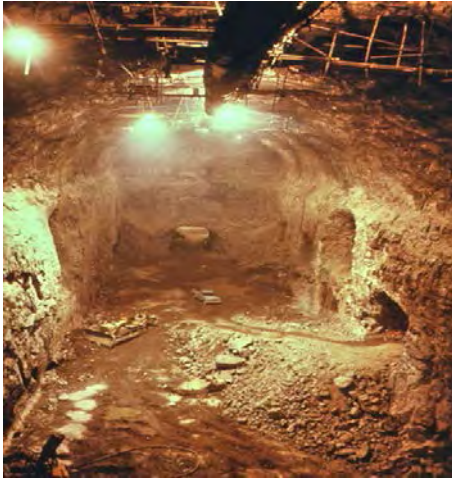
Εικόνα 14: Φάση κατασκευής του υπόγειου θαλάμου του ΥΗΣ του Ρίο Γκράντε (Hoek, 2007)
