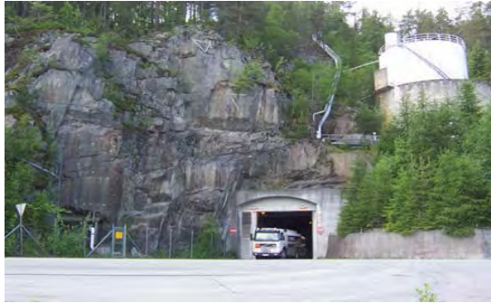
Εικόνα 30: Μεταφορά πετρελαίου από υπόγειο θάλαμο αποθήκευσης στο Τρόντχαϊμ της Νορβηγίας (Broch, 2007)
