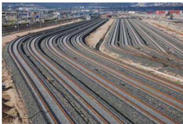
Εικόνα 12: Συγκρότημα εγκαταστάσεων στο Θριάσιο Πεδίο
