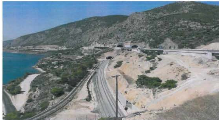
Εικόνα 4: Σήραγγα Κακιάς Σκάλας
