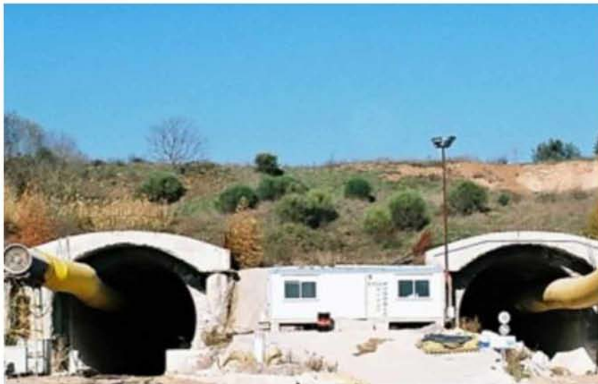
Εικόνα 16: Διάνοιξη σηράγγων στο τμήμα Κιάτο - Ροδοδάφνη
