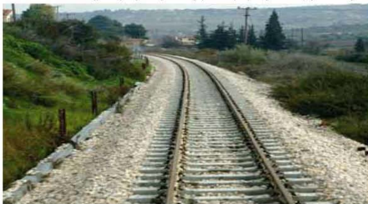
Εικόνα 4: Σιδηροδρομική οδός μεταφοράς – Συμβατική έδραση
