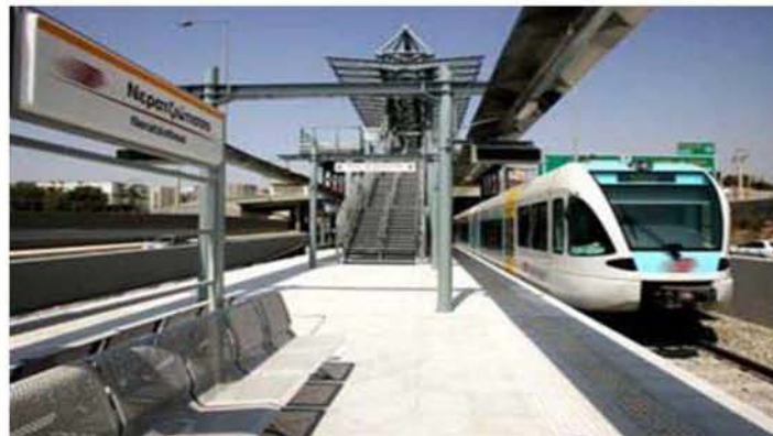
Εικόνα 8: Σταθμός Προαστιακού Σιδηροδρόμου Νερατζιώτισσα
