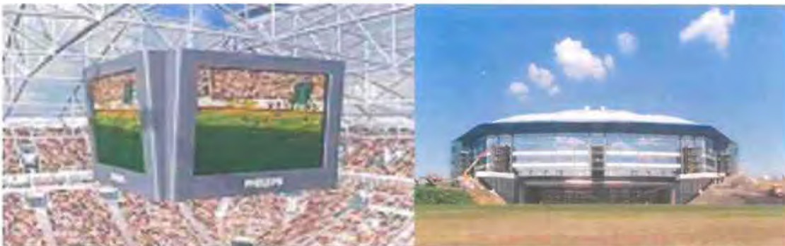
Εικόνα 1.41: λεπτομέρεια από την οροφή του γηπέδου με τις τοποθετημένες εκεί γιγαντοοθόνες καθώς επίσης και από τον εξωτερικό χώρο και συγκεκριμένα την είσοδο-έξοδο του αγωνιστικού χώρου
