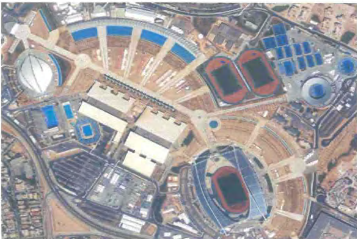
Εικόνα 2.22 : αεροφωτογραφία με τη συνολική Εικόνα των εγκαταστάσεων στο Ολυμπιακό Κέντρο. Εκτός από το στάδιο διακρίνονται το ποδηλατοδρόμιο, το γήπεδο τένις, το κλειστό γήπεδο καλαθοσφαίρισης και γυμναστικής καθώς και το κολυμβητήριο
