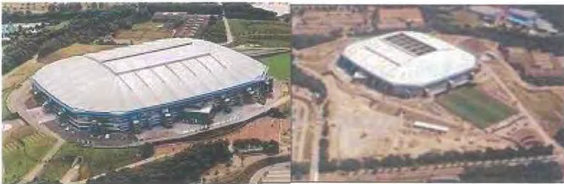
Εικόνα 1.40: το νέο γήπεδο Gelsenkirchen μετά την ανακατασκευή του. Διακρίνεται η ικανότητα της εισόδου-εξόδου του αγωνιστικού χώρου για αλλαγή της χρήσης του.
