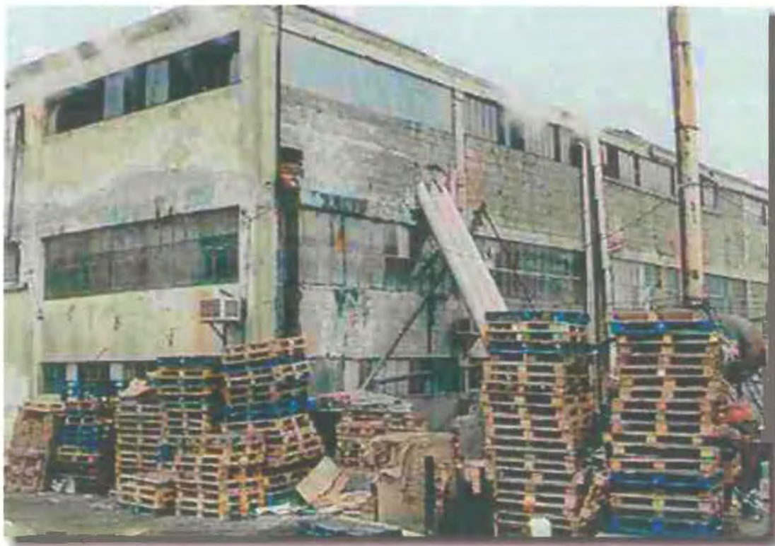
Εικόνα 4.12: εγκαταστάσεις στην περιοχή σήμερα Πηγή: www.minenv.gr
