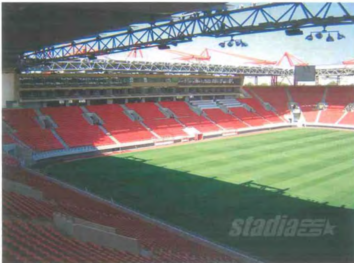
Εικόνα 2.26: εσωτερική άποψη του γηπέδου. Στο βάθος διακρίνονται τα δημοσιογραφικά θεωρεία και οι αίθουσες VIP.
