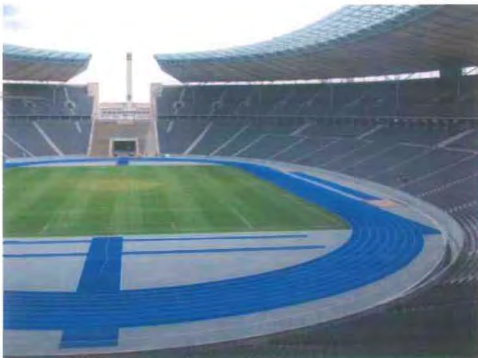
Εικόνα 1.58: άποψη του εσωτερικού του στο τέλος των έργων (μετά την παράδοση στο κοινό)
