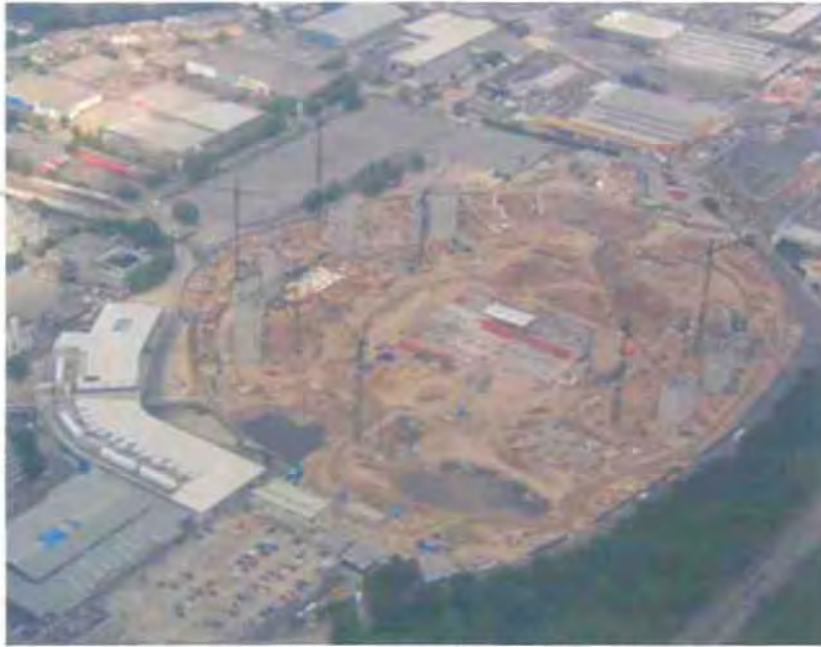
Εικόνα 1.31: τα πρώτα έργα του νέου γηπέδου Πηγή: Πηγή: www.roadie.net
