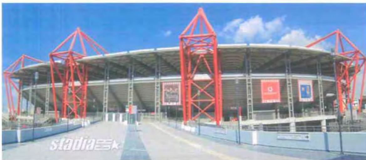
Εικόνα 2.27: το γήπεδο Καραϊσκάκη από την πλευρά του σταθμού του ΗΣΑΠ
