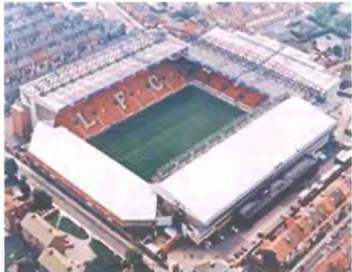
Εικόνα 1.2: άποψη του γηπέδου και του περιβάλλοντα χώρου Πηγή: www.royair.co.uk
