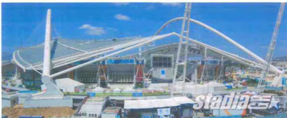
Εικόνα 2.19 : το Ολυμπιακό Στάδιο κατά τη διάρκεια των Ολυμπιακών Αγώνων
