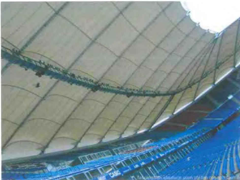
Εικόνα 1.49: άποψη της οροφής του γηπέδου
