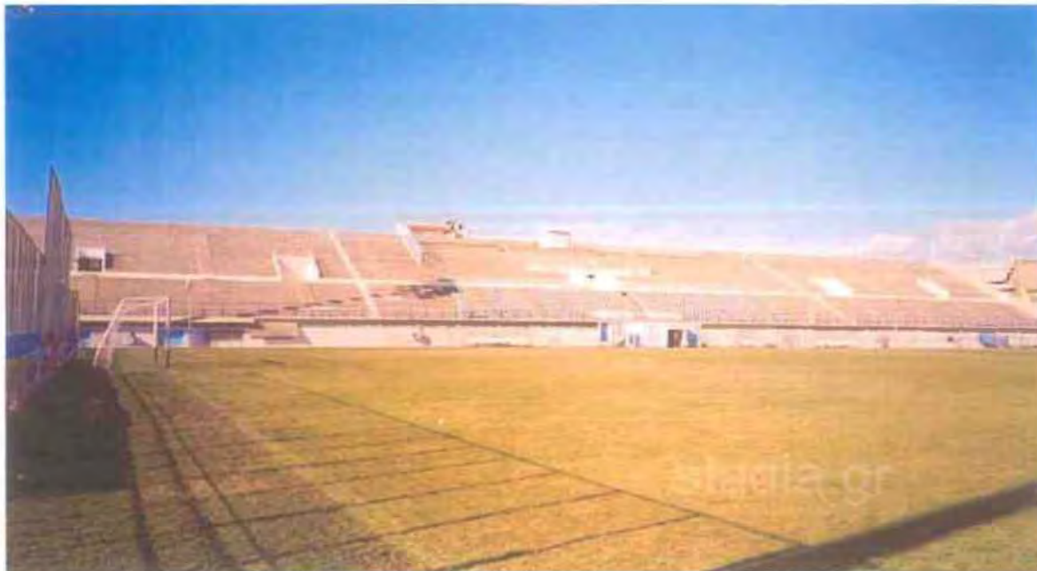
Εικόνα 2.10: το γήπεδο «Σταύρος Μαυροθαλασσίτης» και η κερκίδα που δεν χρησιμοποιείται
