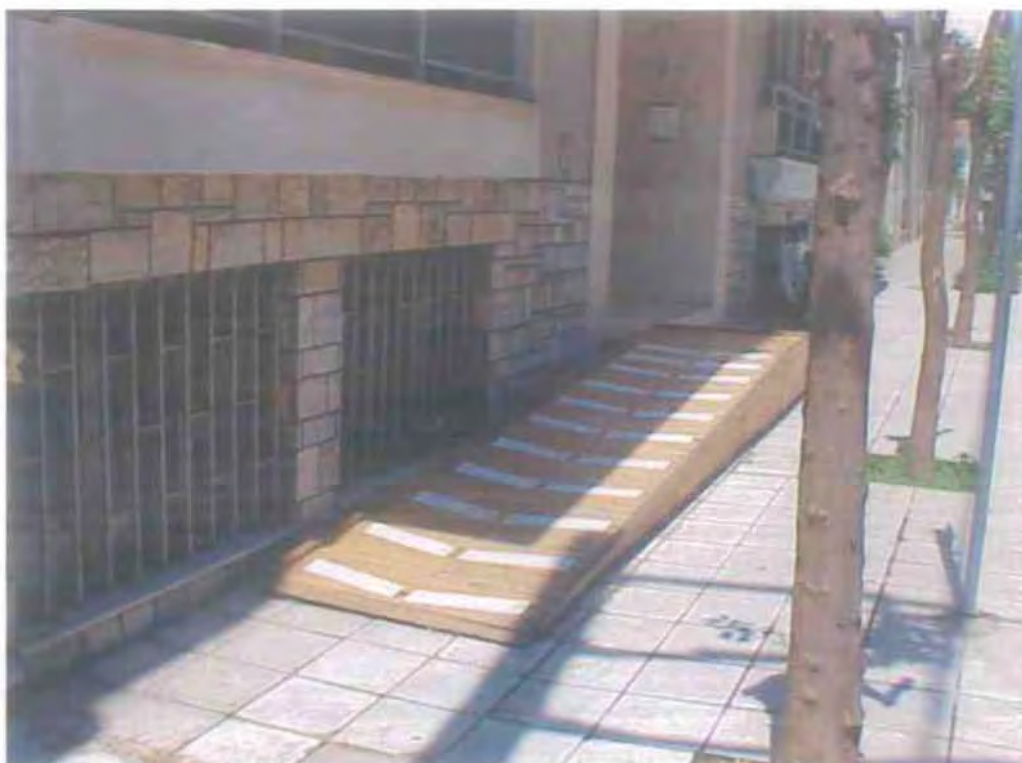
Φωτογραφία 5.3.2: Ράμπα σε είσοδο πολυκατοικίας (Πηγή: Ιδία επεξεργασία).
