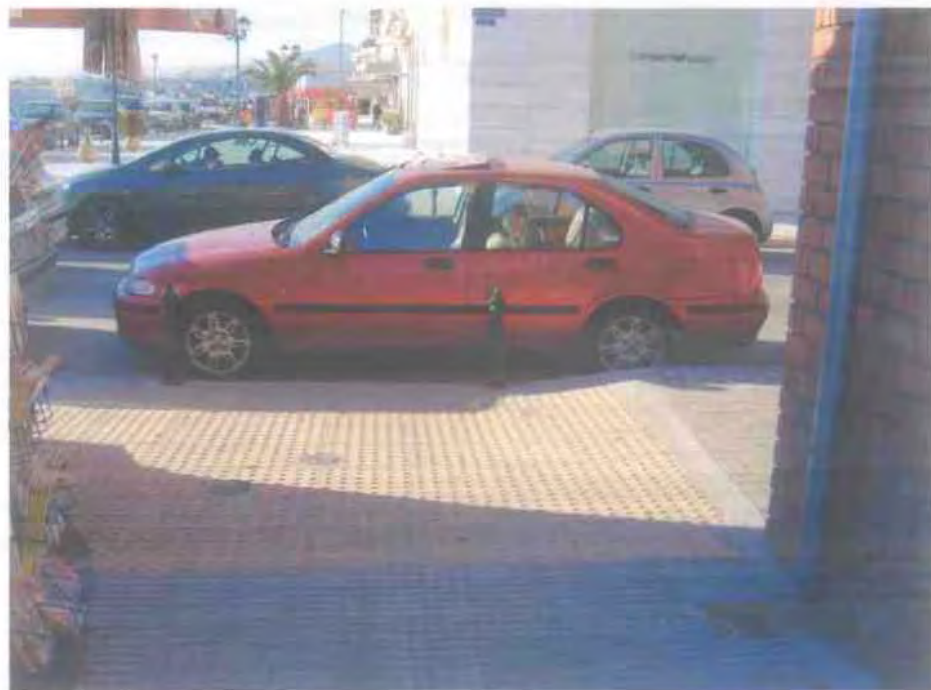
Φωτογραφία 5.2.6: Σκάφη σε πεζοδρόμιο και το παρκαρισμένο αυτοκίνητο που εμποδίζει την πρόσβαση (Πηγή: Ιδία επεξεργασία).
