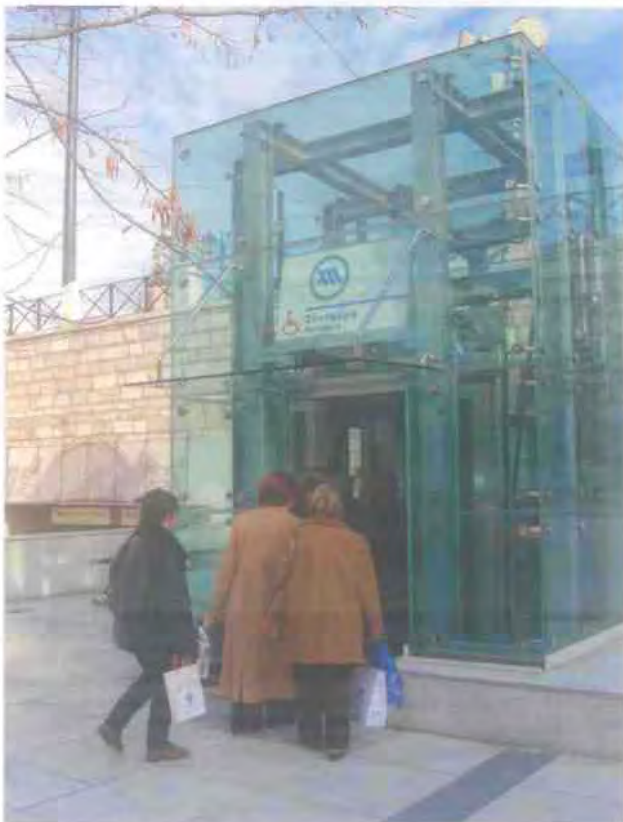
Σχέδιο 3.5.5: Ανελκυστήρας στο ΜΕΤΡΟ (Πηγή: Ίδια Επεξεργασία).
