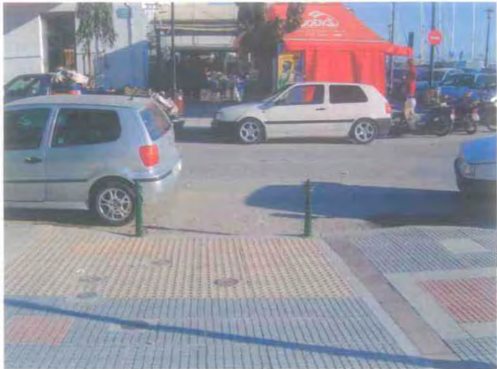
Φωτογραφία 5.2.3: Σκάφη σε πεζοδρόμιο (Πηγή: Ιδία επεξεργασία).
