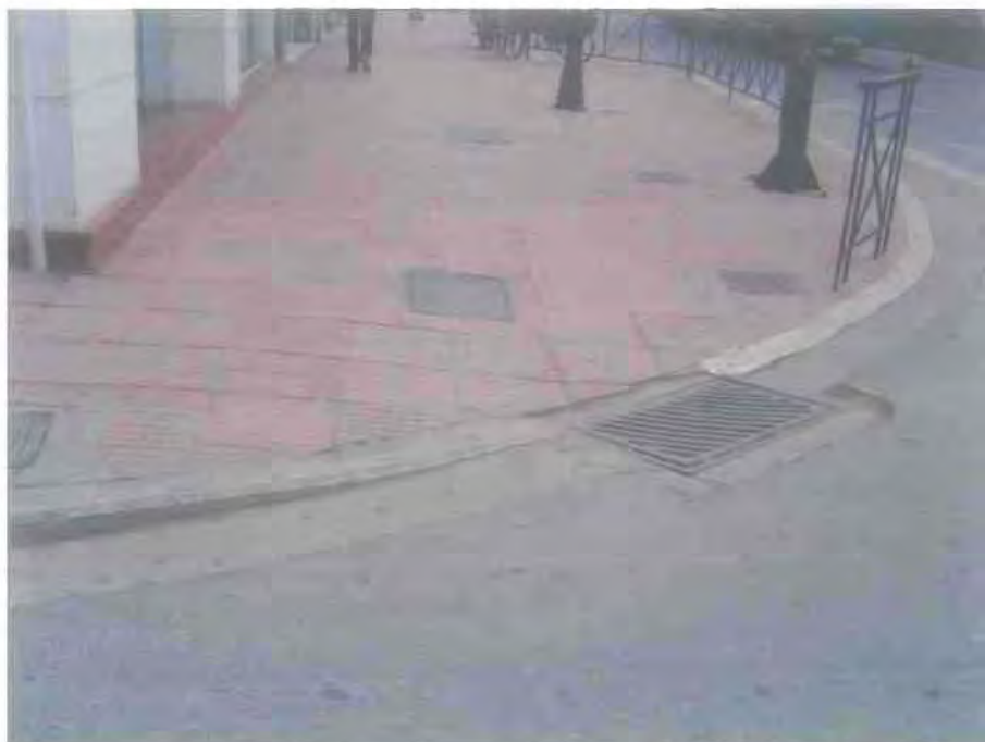
Φωτογραφία 5.2.1: Πεζοδρόμιο στο κέντρο της πόλης (Πηγή: Ιδία επεξεργασία).
