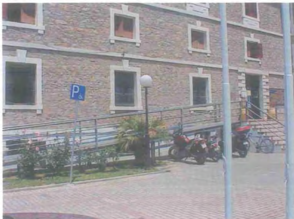
Φωτογραφία 5.2.15: Το κτίριο Σπίερ (Πηγή: Ιδία επεξεργασία).
