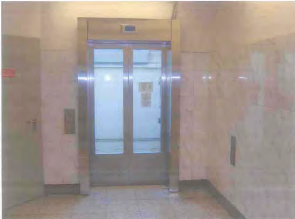
Σχέδιο 3.5.1: Ανελκυστήρας στο ΜΕΤΡΟ (Πηγή: Ίδια Επεξεργασία).
