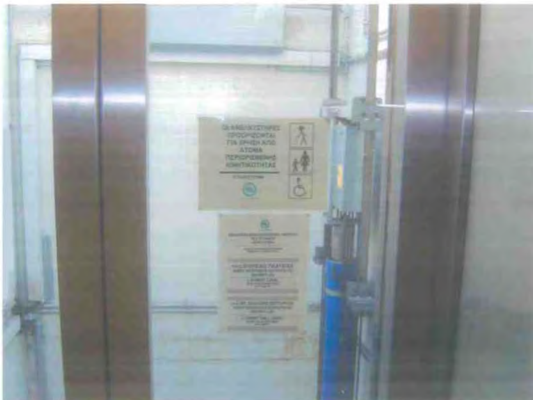
Σχέδιο 3.5.2: Ανελκυστήρας στο ΜΕΤΡΟ (Πηγή: Ίδια Επεξεργασία).
