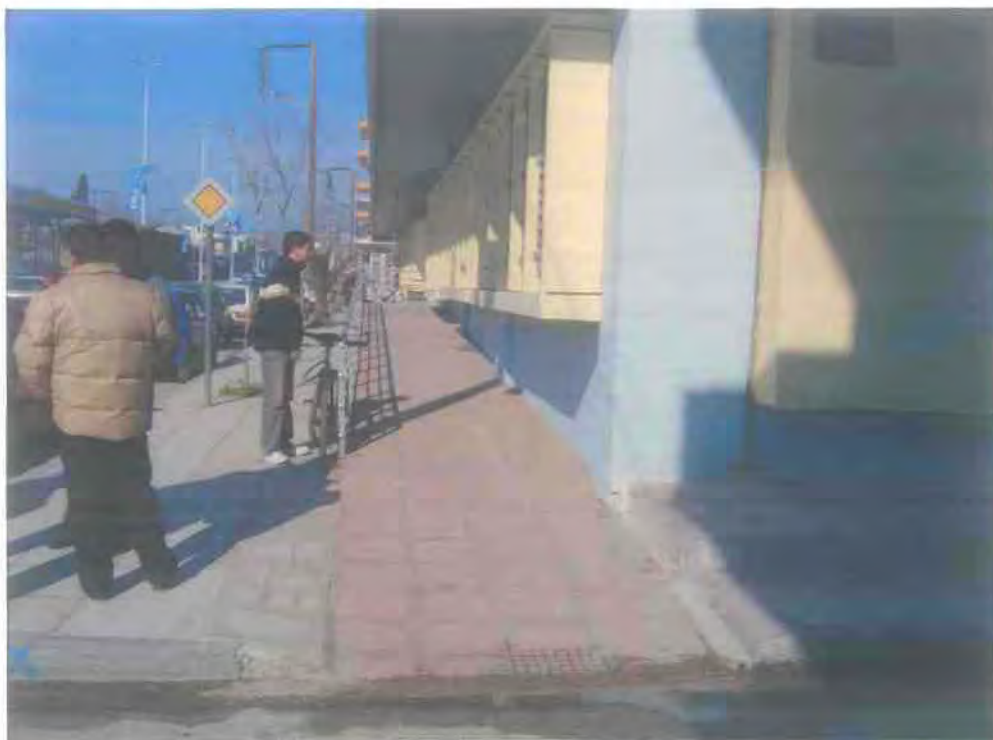
Φωτογραφία 5.2.12: Το κτίριο της ΔΕΗ (Πηγή: Ιδία επεξεργασία).
