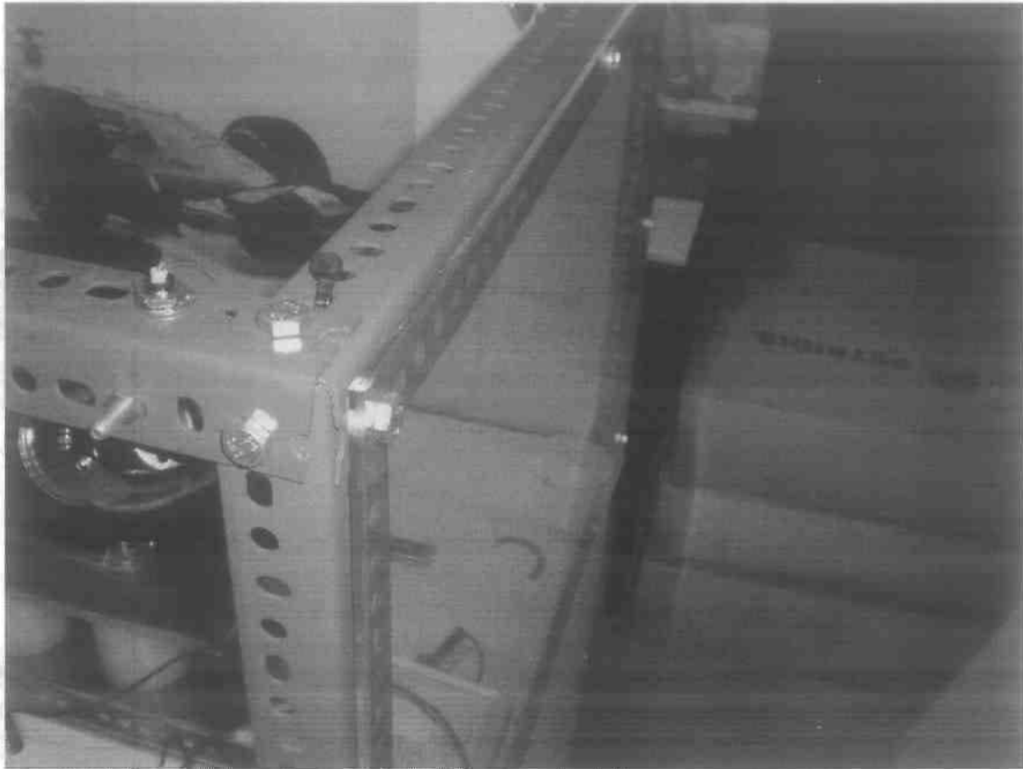
47) Προστατευτικά τοιχώματα τύπου plexiglass
