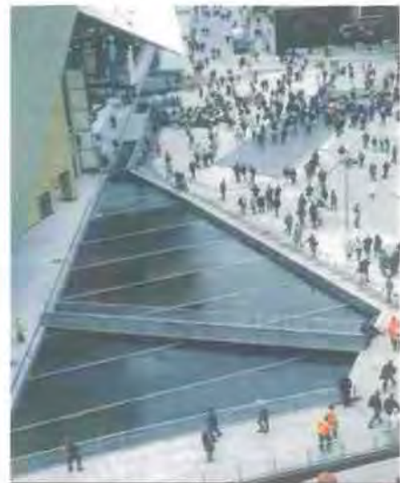
Εικόνα 4: Σχέδιο και Φωτογραφία με το σύστημα συλλογής των νερών της βροχής του κτιρίου της Daimler-Chrysler στην Potsdamer Platz, Βερολίνο, Γερμανία
