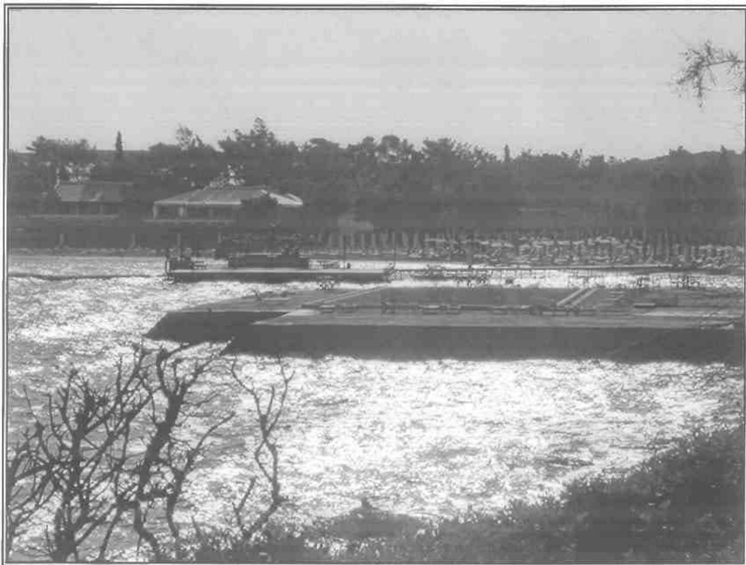
ΦΩΤΟΓΡΑΦΙΑ 5 : Κατασκευή πισίνας μέσα στην Θάλασσα σε ξενοδοχείο στο Λαγονήσι (2004)
