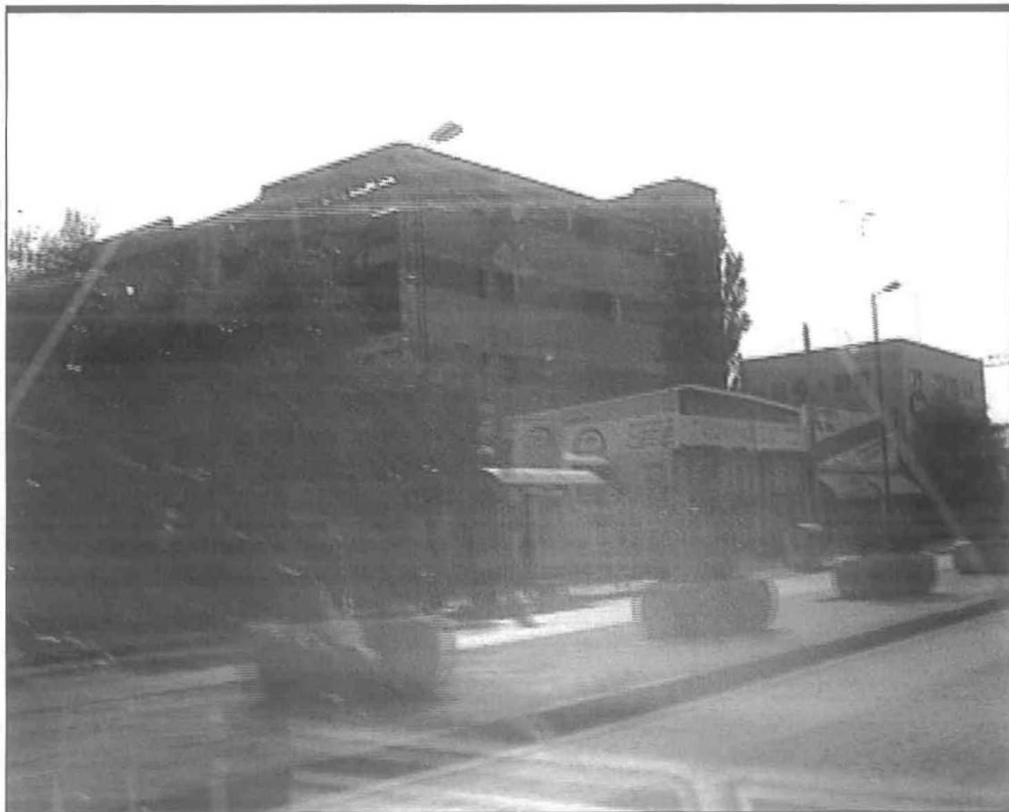
ΕΡΓΟΣΤΑΣΙΟ ΑΘΗΝΑΪΚΗΣ ΧΑΡΤΟΠΟΙΙΑΣ SOFTEX ΜΕΤΑ ΤΗΝ ΚΑΤΑΣΤΡΟΦΗ ΤΟΥ ΑΠΟ ΠΥΡΚΑΓΙΑ ΠΑΡΑΜΕΝΕΙ ΑΝΕΚΜΕΤΑΛΛΕΥΤΟ
