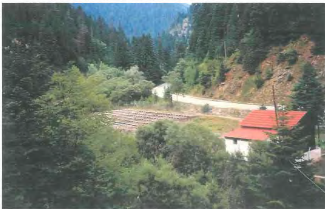
Εικ.2: Ο πεστροφογεννητικός σταθμός στην τοποθεσία Κουκουφλί
