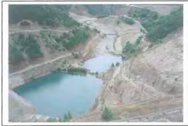
Εικόνα 3.9: Άποψη του Αχελώου ποταμού μετά το φράγμα
