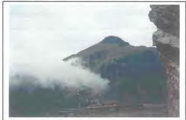
Εικόνα 3.6: Ε.Ο. Τρικάλων Άρτης τμήμα υπό κατασκευή
