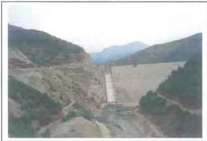
Εικόνα 3.7: Όψη του φράγματος
