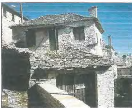
Φωτ. 25 Εγκατελειμένο κτίριο.
