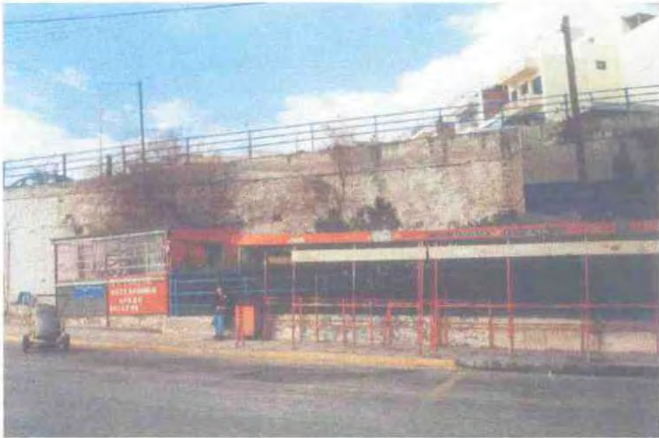
Εγκαταστάσεις του Κ.Τ.Ε.Α. Νομού Αττικής στο Δήμο Ραφήνας
