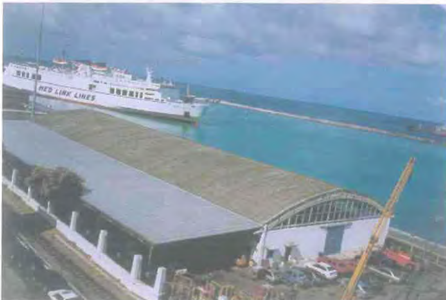
Φωτ. 3: Υπόστεγο παραλιακού κρηπιδόματος
