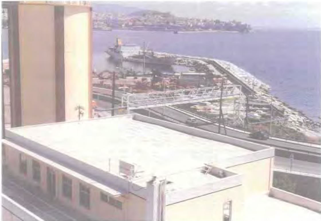
Φωτογραφία 5.4 : Οι εγκαταστάσεις της ΑΓΕΤ-Ηρακλής και πλοίο της εταιρείας τη στιγμή της εκφόρτωσης τσιμέντου. Διακρίνεται ο αγωγός και η αντιαισθητική γεφυρωτή κατασκευή πάνω από το δρόμο.
