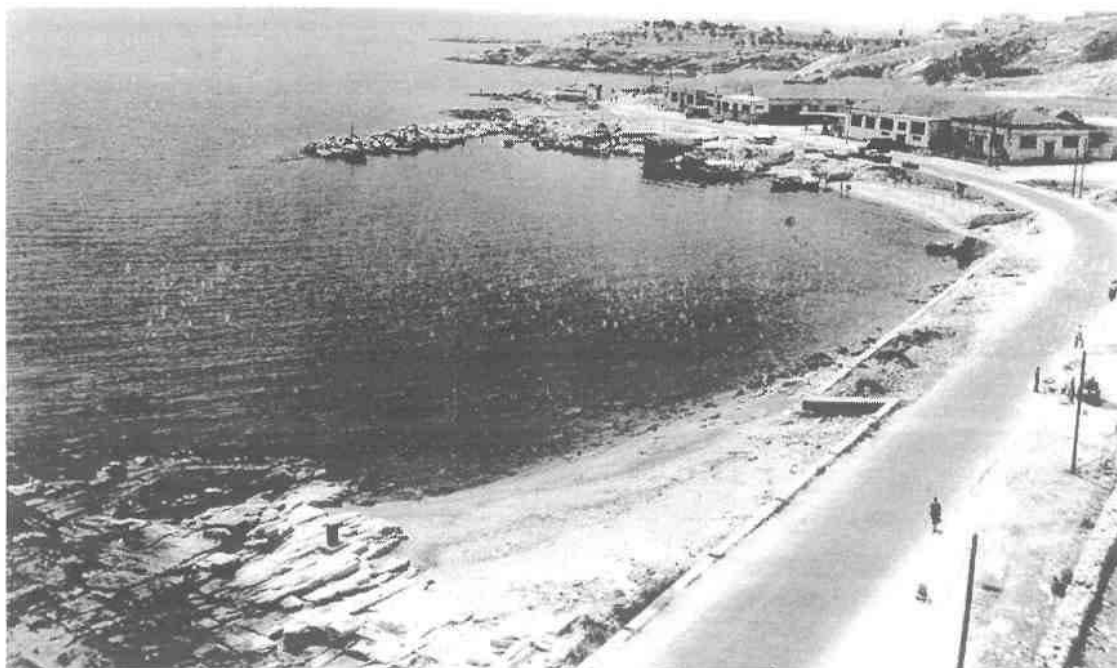
Φωτογραφία 5.2 : Η Ιχθυόσκαλα το 1956. Τα πρώτα λιμενικά έργα (πηγή: Λιμενικό Ταμείο Καβάλας)
