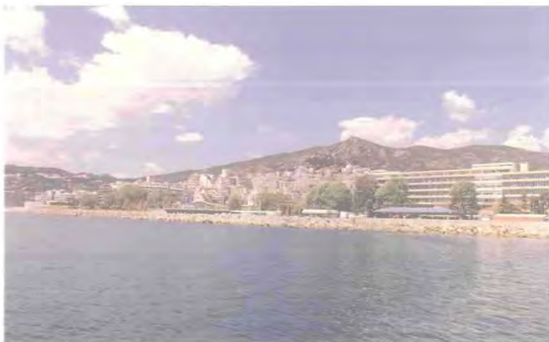
Φωτογραφία 3.5.α: Το δυτικό τμήμα της ακτής Διοικητηρίου με το δημοτικό πάρκο (αριστερά) και το κτίριο του Διοικητηρίου (δεξιά).
