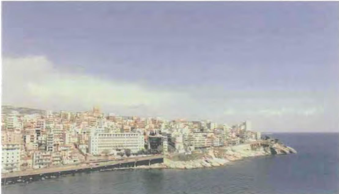
Φωτογραφία 3.8 : Οι απόκρημνες ακτές της Αγ. Βαρβάρας. Διακρίνεται το κτίριο του Νοσοκομείου (κέντρο) και η υπερυψωμένη οδική αρτηρία.
