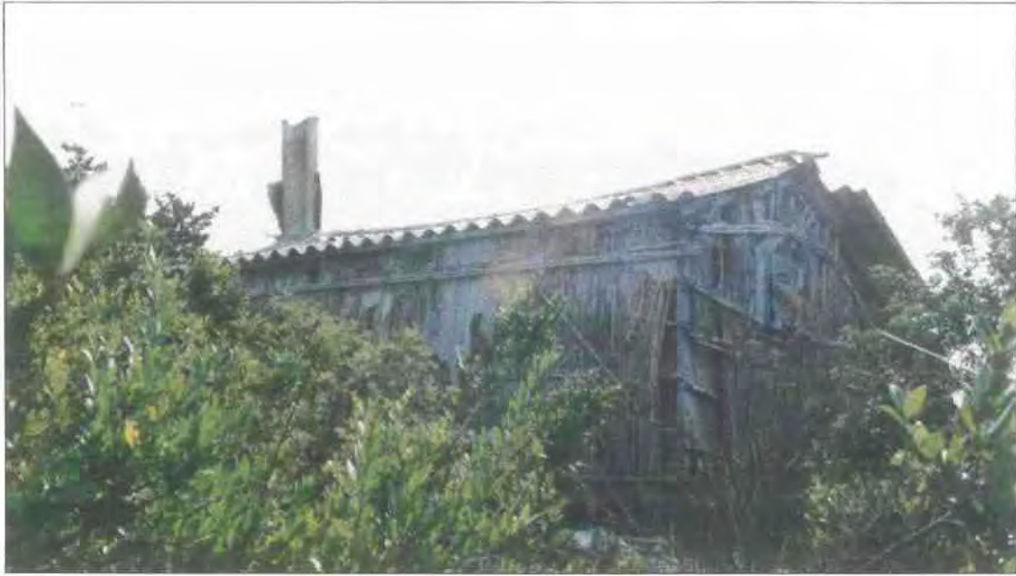
Εικόνα 19: Καλαμοκατασκευή με στέγη από λαμαρίνα μέσα σε μακία βλάστηση.
