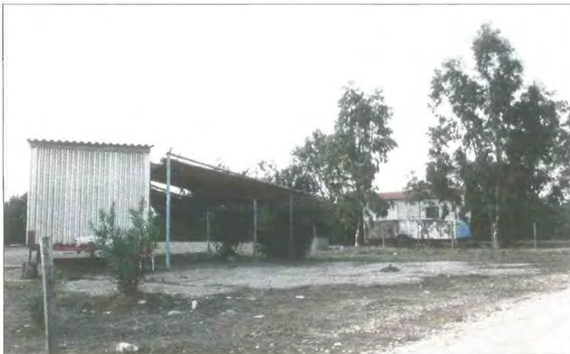
Εικόνα 20: Ελαφριές κατασκευές στέγασης στον ανατολικό Λούρο. Διακρίνεται φυτεμένοι ευκάλυπτοι και πικροδάφνες.
