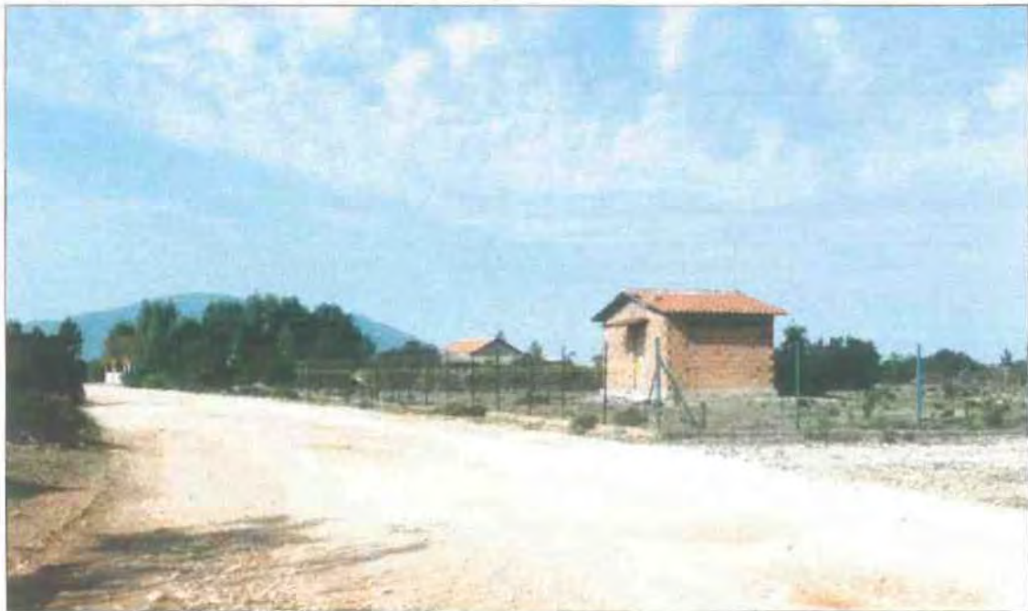
Εικόνα 17: Περιφραγμένος τυπικός οικίσκος από οπτοπλινθοδομή σε βάση από βέση στον κεντρικό δρόμο του ανατολικού Λούρου.
