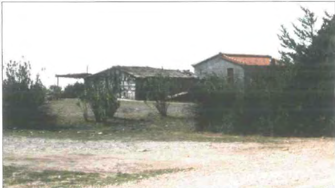
Εικόνα 15: Τυπικοί οικίσκοι στο δυτικό Λούρο. Διακρίνονται στον αριστερό η καλαμοσκεπή και στον δεξιό η πλινθοδομή.
