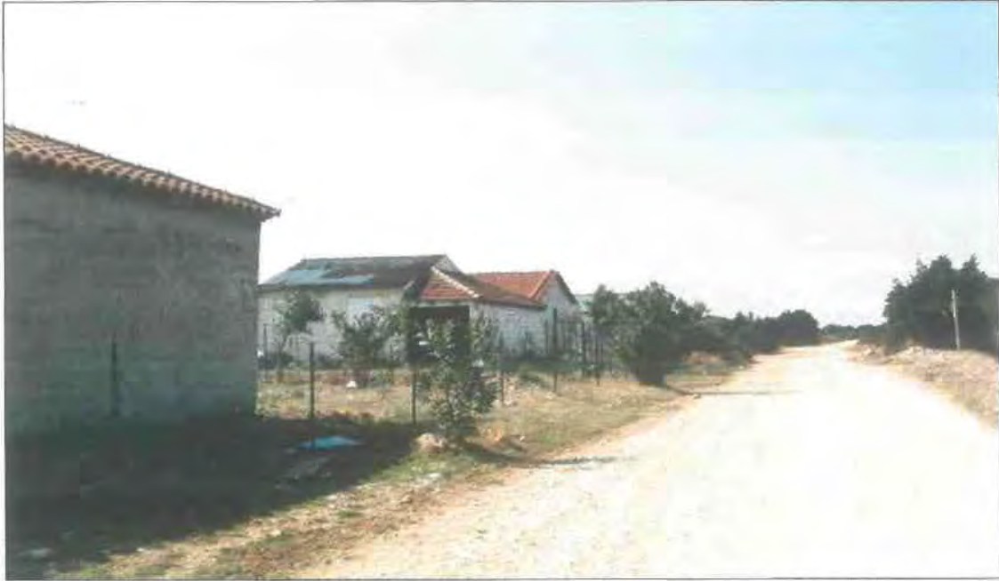
Εικόνα 14: Τυπικοί οικίσκοι από τσιμεντόλιθους με περίφραξη στον κεντρικό δρόμο του ανατολικού Λούρου. Οι σκεπές είναι από λαμαρίνα και κεραμίδι.
