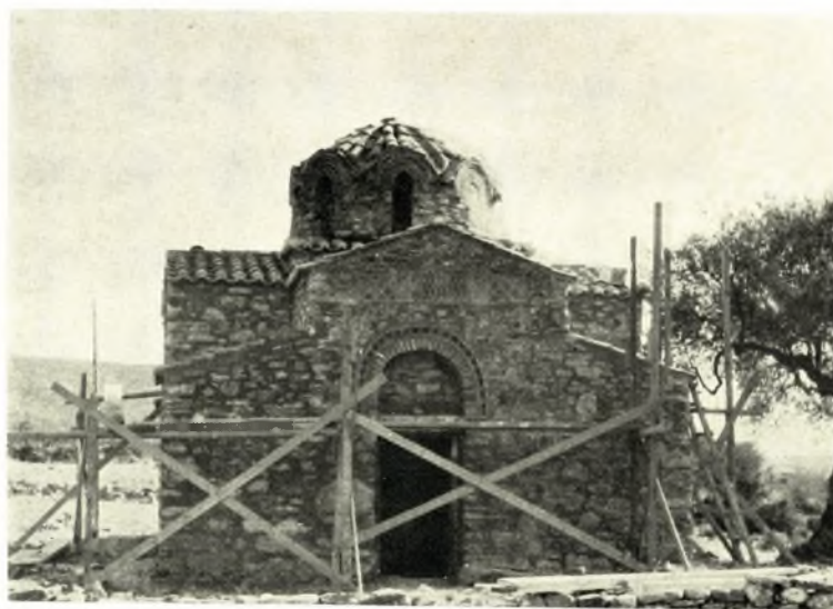
Λακωνία. Χρύσαφα. Ναός Ἁγ. Ἰωάννου: α - β. Ἡ πρόσοψις πρὸ καὶ κατὰ τὴν διάρκειαν τῶν ἐργασιῶν
