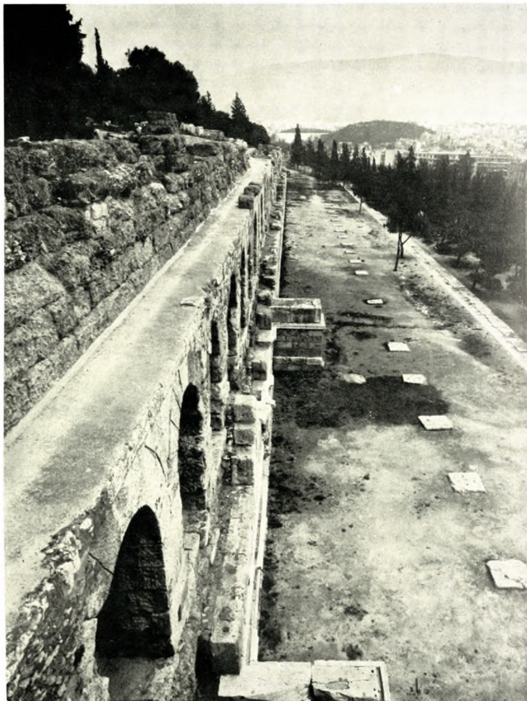
Ἄθηναι. Στοὰ Εὐμένους: Ὁ χώρος μετὰ τὰς ἐργασίας διαμορφώσεως
