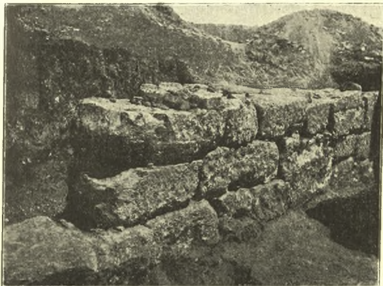
Εἰκ. 6. Τοίχος μισημβρινὸς οἰκοδομήματος B.
