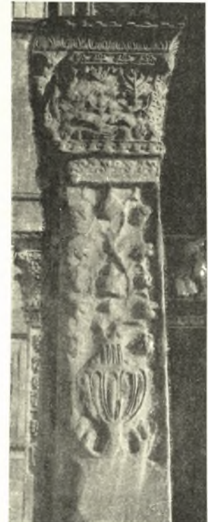
Είκ. 9. Δυτικὸς πεσσός. Δυτικὴ πλευρά.
