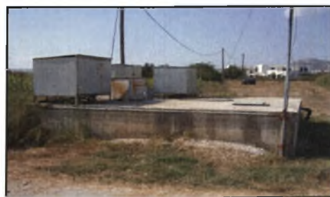
Εικόνα 4.2. Δεξαμενή νερού γεώτρησης αγροκτήματος Βελεστίου
