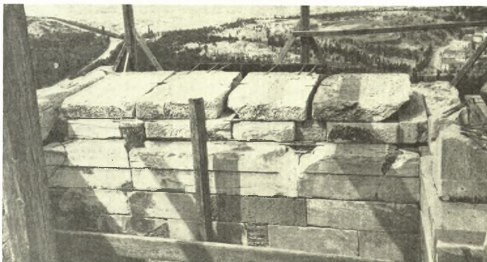
Εἰκ. 8. Καλυμμάτια τῆς ὀροφῆς τῆς δυτικῆς προστάσεως θεώμενα ἐκ τῶν ἄνω. Χαρακτηριστικὴ ἐπεξεργασία λωρίδων εἰς τέσσαρα καλυμμάτια.
