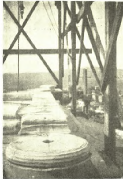
Εἰκ. 30. Ἡ βάσις τοῦ ΒΑ κίονος, ἐν ἣ ἐμφαίνεται ἡ χάραξις τοῦ ἀξονος κατ' ἐπέκτασιν τοῦ τῆς σπείρας. (Φωτογρ. Τ. Βόγλη).
