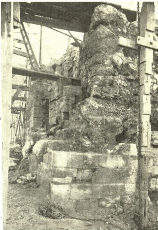
Εἰκ. 18. Ἐποψὶς τῆς ΝΔ γωνίας τοῦ Πελασγικοῦ τείχους, εἰς ἣν ἐμφαίνονται οἱ ἐπὶ τοῦ βράχου λαξευτοὶ ἀναβαθμοὶ πρὸς ἔδρασιν τῶν σχετικῶν δόμων τοῦ περιβλήματος ὡς καὶ οἱ τοποθετηθέντες κατὰ τὸ 1901 λίθοι πρὸς στερεώσιν τῆς βάσεως τῆς ΝΔ γωνίας τοῦ περιβλήματος.
