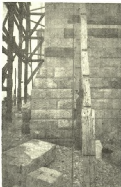
Εἰκ. 27. Ἡ ΝΔ γωνία τοῦ ἀνακατασκευασθέντος περιβλήματος.
