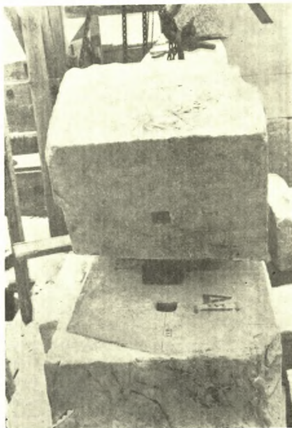
Εἰκ. 31. Χάραξι ἀξόνων τετραγώνου λαξεύματα πρὸς ἐναπόθεσιν ὄρειχαλκίνης θήκης εἰς δύο ὑπερκειμένους λίθους τῆς αὐτῆς παραστάδος. (Φωτογρ. Τ. Βόγλη).
