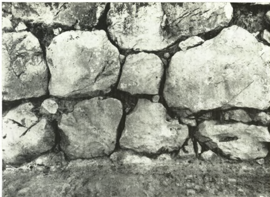
α. Χαρακτηριστική υποθεμελίωσις τοῦ δυτικοῦ κυκλωπειοῦ τείχους.
