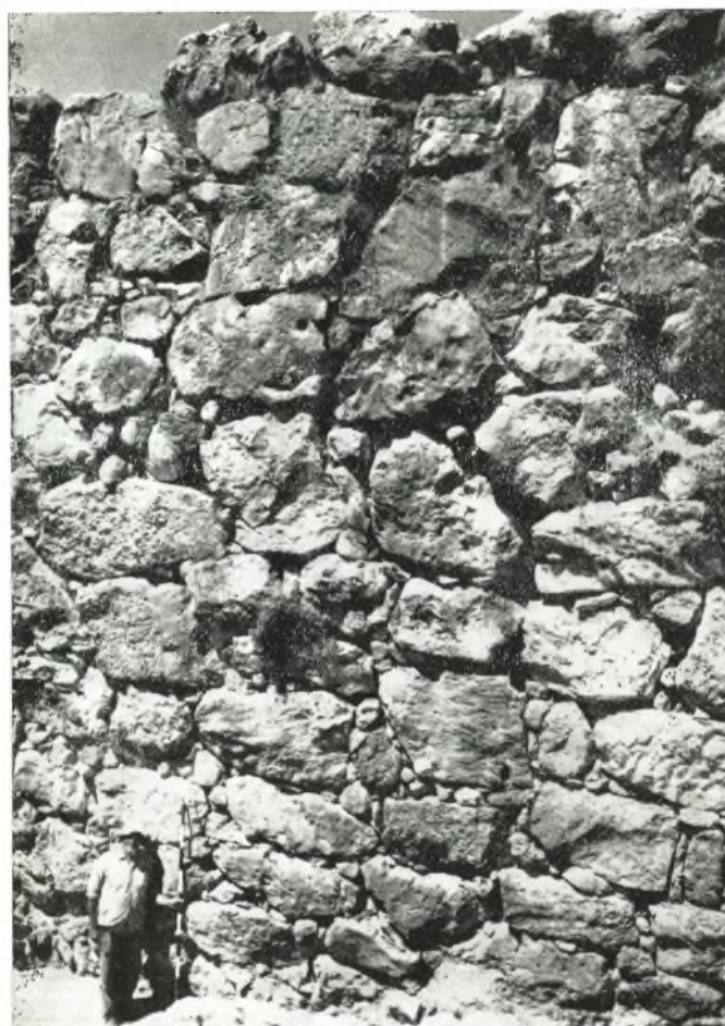
Εἰκ. 63. Ἐσωτερικὴ ὄψις τοῦ δυτικοῦ κυκλωπέου τείχους. Ὑψος ἀπὸ τοῦ βράχου 8.25 μ.
