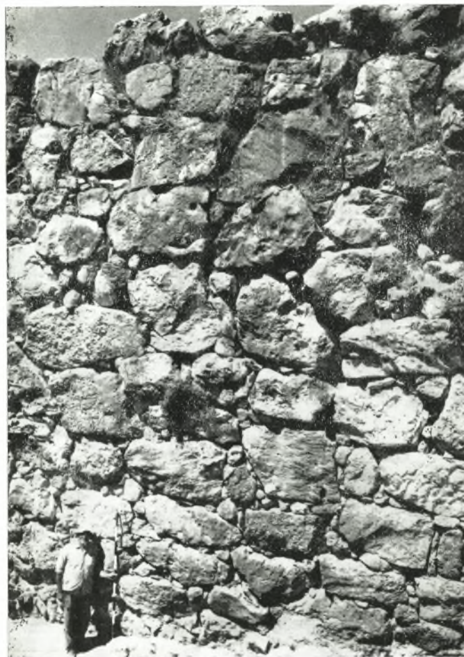
Εἰκ. 63. Ἐσωτερικὴ ὄψις τοῦ δυτικοῦ κυκλωπέου τείχους. Ὑψος ἀπὸ τοῦ βράχου 8.25 μ.
