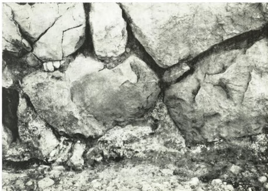
β. Χρῆσις ἀσπροχάματος εἰς τὴν υποθεμελίωσιν τοῦ δυτικοῦ κυκλωπειοῦ τείχους.
