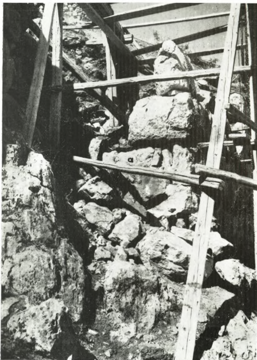
Εἰκ. 31. Βόρειον κυκλώπειον τείχος. Τὸ τμήμα Μ κατὰ τὴν ἀναστήλωσιν.
