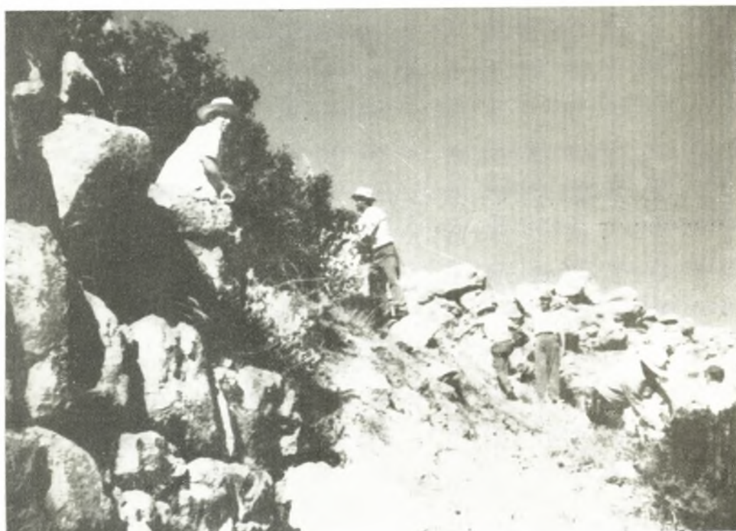
Εἰκ. 30. Βόρειον κυκλώπειον τείχος. Τμήμα Ν πρὸ τῆς ἀναστηλώσεως.
