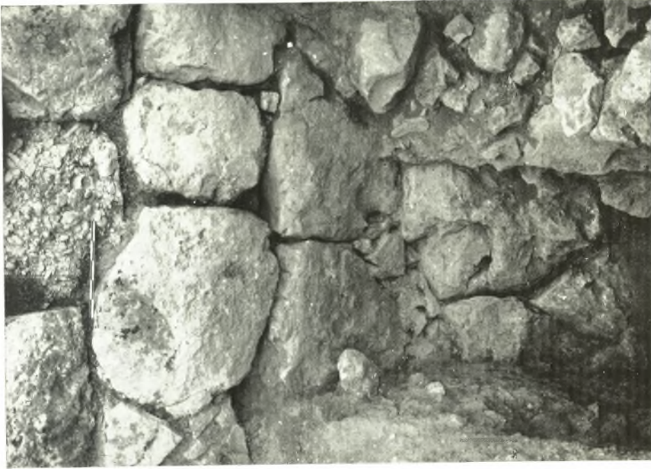
β. Υποθεμελίωσης του βορείου κυκλαπτείου τείχους εις την περιούχην Δ.
