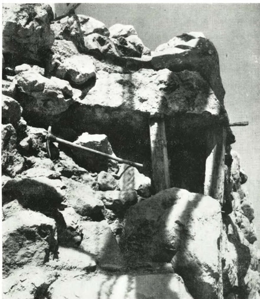
Εἰκ. 32. Βόρειον κυκλόπειον τεῖχος. Τὸ τμήμα Ν κατὰ τὴν ἀναστήλωσιν.
