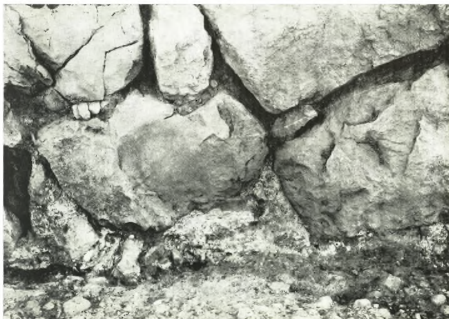
β. Χρῆσις ἀσπροχώματος εἰς τὴν υποθεμελίωσιν τοῦ δυτικοῦ κυκλωπειοῦ τείχους.
