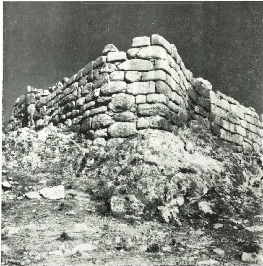
Εἰκ. 35. Τὸ βορειοδυτικὸν ἄκρον τοῦ περιβόλου ὡς νῦν ἔχει μετὰ τὴν ἀναστήλωσιν.
