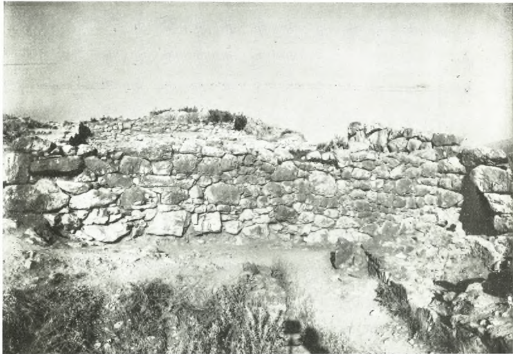
Εἰκ. 10. Ὁ ἀναλημματικός τοῖχος Κ παρὰ τὴν εἴσοδον τῆς ὑπογείου δεξαμενῆς.
