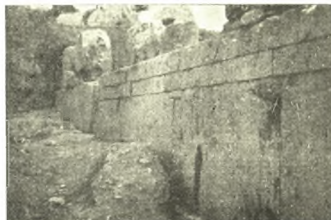
Εἰκ. 11. Τὸ ἀνατολικώτερον τμήμα τοῦ βορείου περιβόλου ἑλληνικοῦ κτίσματος Πολυρῶνης.
