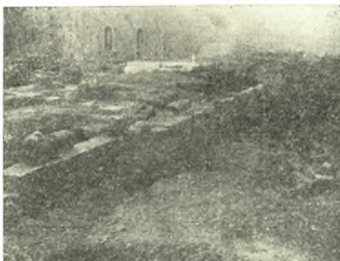
Εἰκ. 7. Ὁ βόρειος τοῖχος περιβόλου ἑλληνικοῦ κτίσματος Πολυῤῥηνίας.
