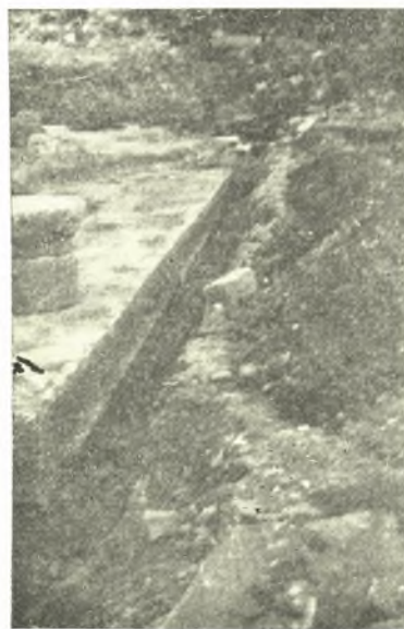
Εἰκ. 15. Στερεοβάτης μετὰ τοῦ πρώτου δόμου τοῦ κρηπιδώματος τοῦ Β τοῖχου ἑλληνικοῦ κτίσματος Πολυῤῥηνίας.
