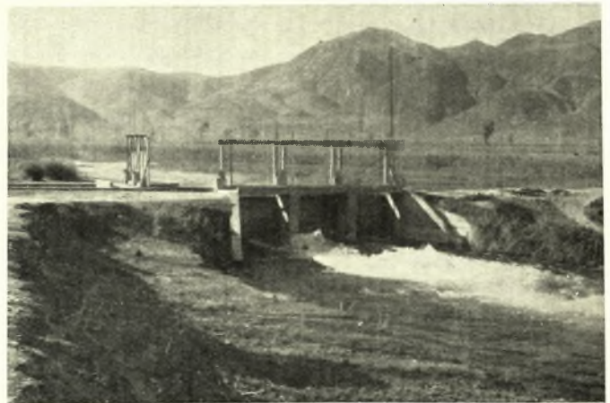
Φράγμα ἐκτροπῆς ὑδάτων εἰς Μάτι Τυρνάβου
