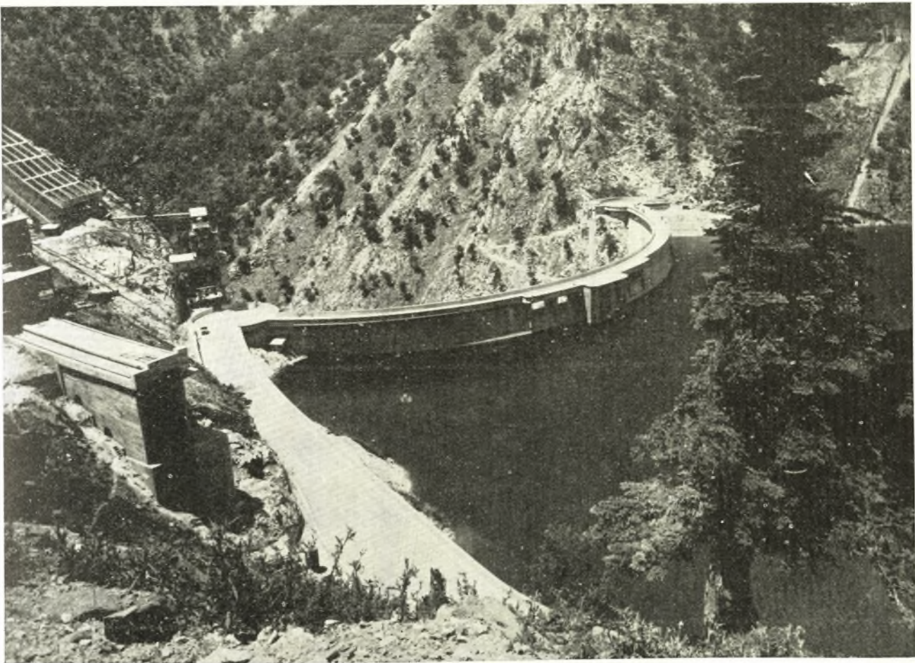
Τεχνητὴ λίμνη τοῦ Ταυρωποῦ: Τὸ φράγμα.
