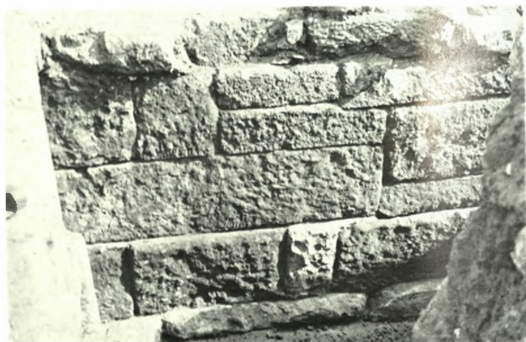
Α. Μακεδονία. Ἴλβδῆρα: α. Γωνία τοίχων κτηρίου 4ου-3ου π.Χ. αἰ., β. Λεπτομέρεια κατασκευῆς τοίχου τοῦ κτηρίου τῆς εἰκ. α.
