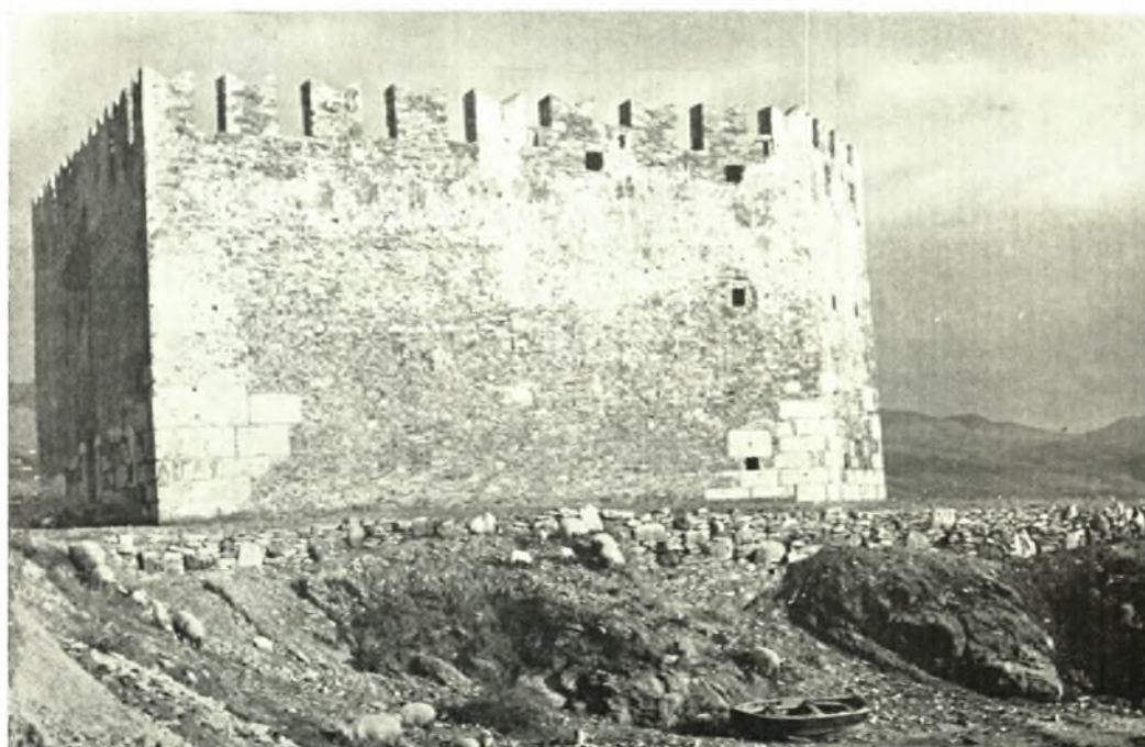
Εύβοια. Κάρυστος: α-β. Ἡ δυτική πλευρά τοῦ ὄχυροῦ Μπούρτζι πρὸ καὶ μετὰ τὴν ἐπίσκευήν
