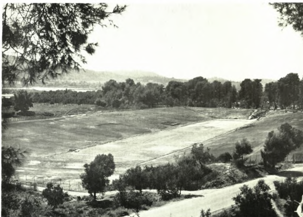
Olympia. Stadion nach der Wiederherstellung September 1962: a. von Westen, b. von Nordosten
