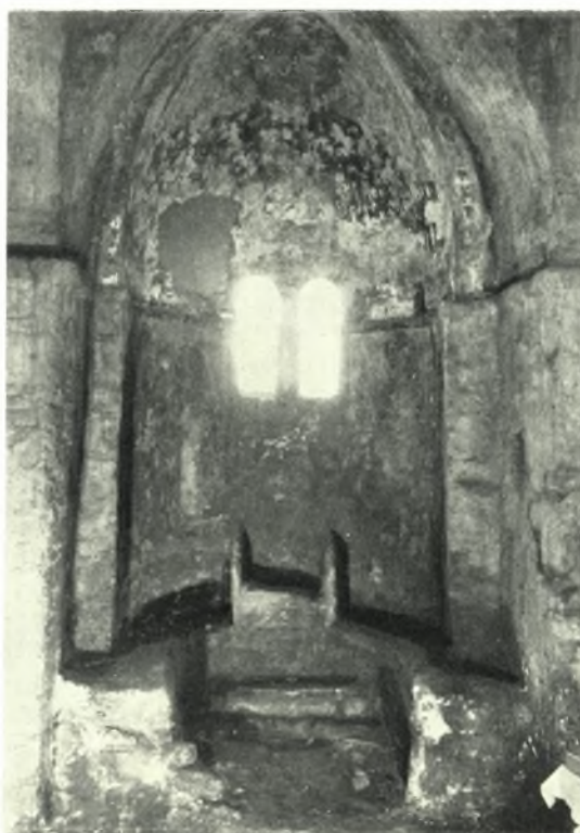
Νάξος. Ναός Δροσιανῆς: α - β. Τὸ ἀνατολικὸν παρεκκλήσιον καὶ ἡ ἀψὶς αὐτοῦ μετὰ τὰς στερεωτικὰς ἐργασίας
