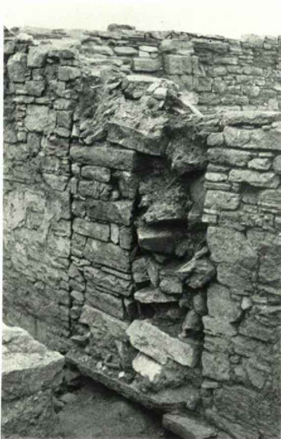
Délos. Skardhana. Habitation I: a. Le mur tardif, b. Le bouchage de la porte
