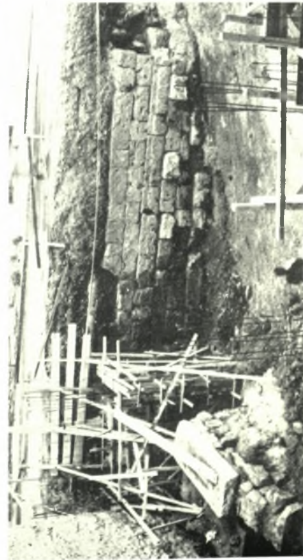
Βύροια. Οικόπεδον Καραντουμάνη: α - γ. Απόψεις από Ν. και Α. του υποκείμενου τοίχου
