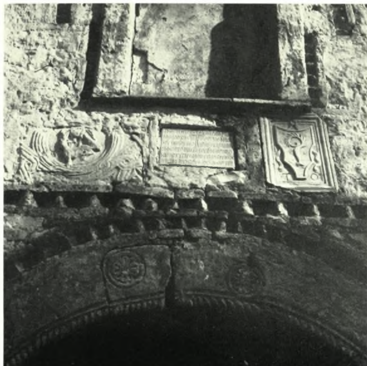
Αίτωλοακαρνανία. Μονή Ἁγίου Ἰωάννου Βομβοκοῦς: α. Τὸ Καθολικὸν τῆς Μονῆς μετὰ τὰς ἐργασίας, β. Ἐπιγραφή ὑπὲρ τὴν δυτικὴν εἰσοδὸν
