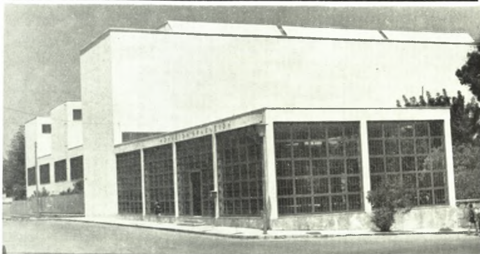
Κρήτη. Μουσείον Ἡρακλείου : α. Κράνος ἐξ ὀδόντων συός ἐκ Ζαφὲρ Παπούρας, β. Μακίττα τῆς « βασιλικῆς ἐπαύλεως » Κνωσοῦ, γ. Πρόσοψις τοῦ Μουσείου μετὰ τὰ ἔργα συντηρήσεως καὶ ἐγκαταστάσεως ἀλεξικεραύνου
