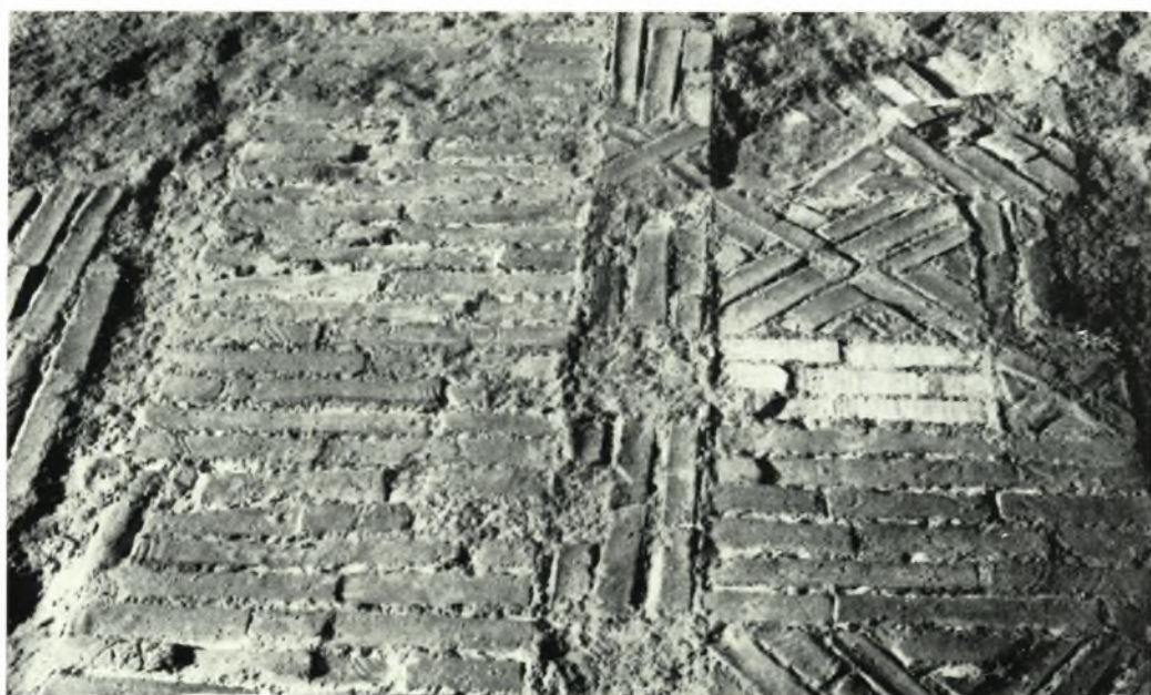
Δίον Πιερίας. Βασιλική Α: α. Τὸ δυτικὸν ἄκρον τῆς σολέας μετὰ τμήματος τοῦ ἐκ πλινθίνων σχεδίων δαπέδου, β. Τμήμα τοῦ δαπέδου τῆς σολέας ἐκ πλίνθων
