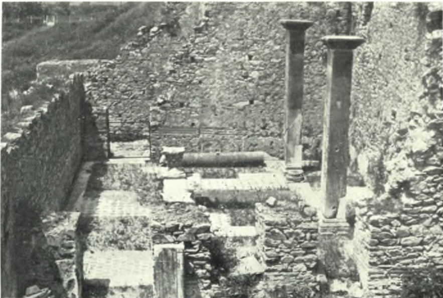
Φίλιπποι. Βασιλική Α: α - β. Οί δύο μονολιθικοί πεσσοί τοῦ βαπτιστηρίου μετὰ τὴν τοποθέτησίν των ἐπὶ τῶν βάσεων των
