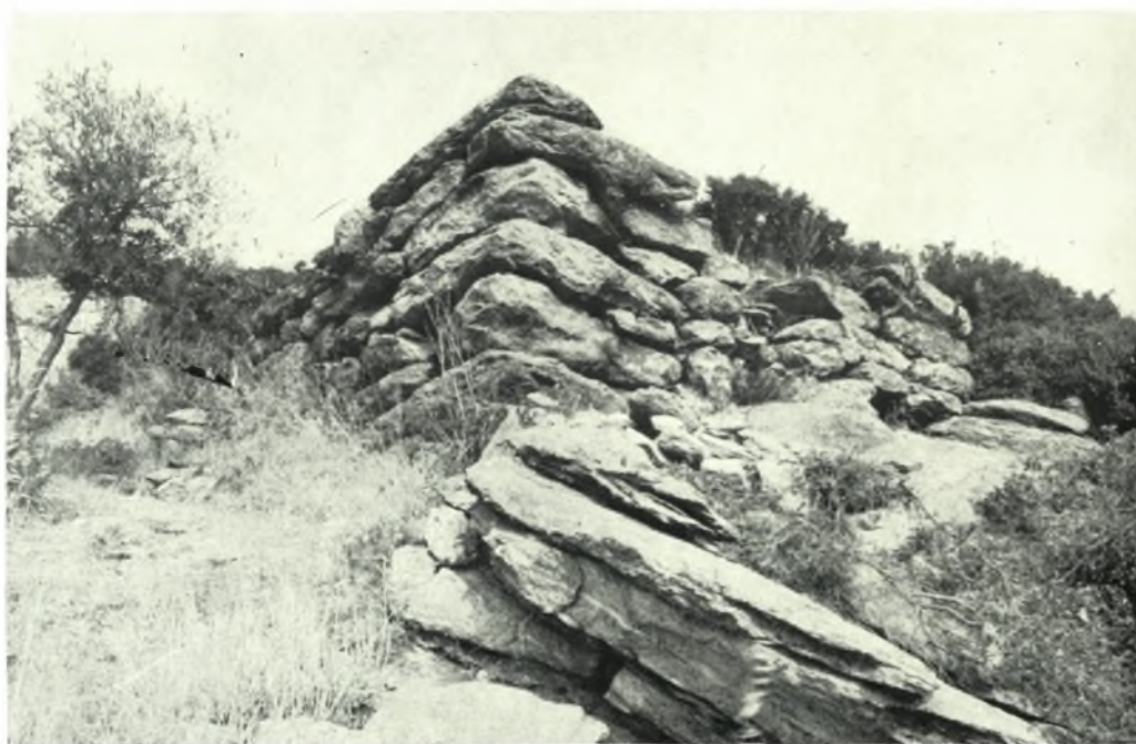
Καβάλα. Οϊσύμη: α. Τμήμα τείχους δυτικής κλιτύος, β. ΝΑ. πύργος τοῦ τείχους
