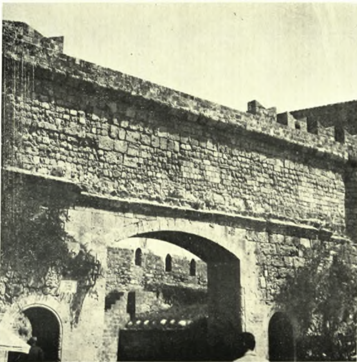
Ρόδος: α - β. Νεωτέρα "Πύλη τῆς Ἐλευθερίας" (νοτιά ὄψεις) πρὸ καὶ μετὰ τὸ πέρας τῶν ἐργασιῶν στερεώσεως τῆς ἐπιφανείας τοῦ ὑπερκειμένου τοῖχου
