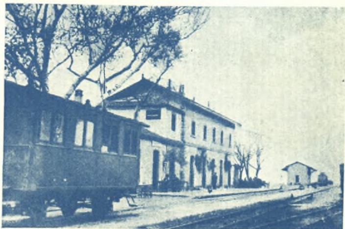
Φάρσαλα: Ὁ σιδηροδρομικὸς σταθμὸς ἔξωθεν τῆς κωμοπόλεως
