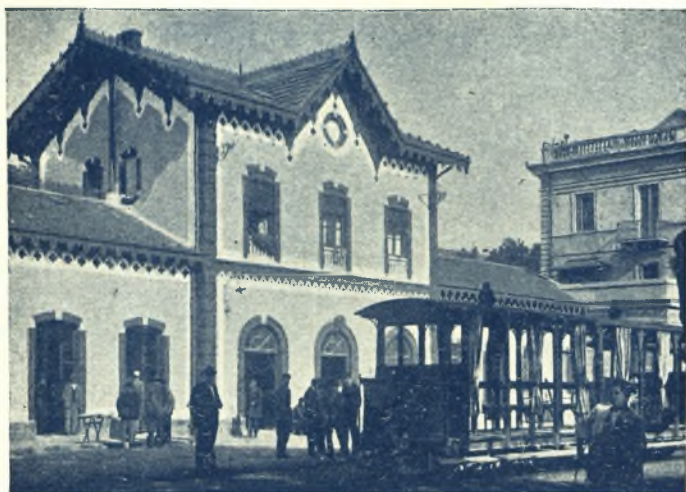
Βόλος: Ὁ Σταθμός Θεσσαλικῶν Σιδηροδρόμων ἐν Παλαιοῖς
