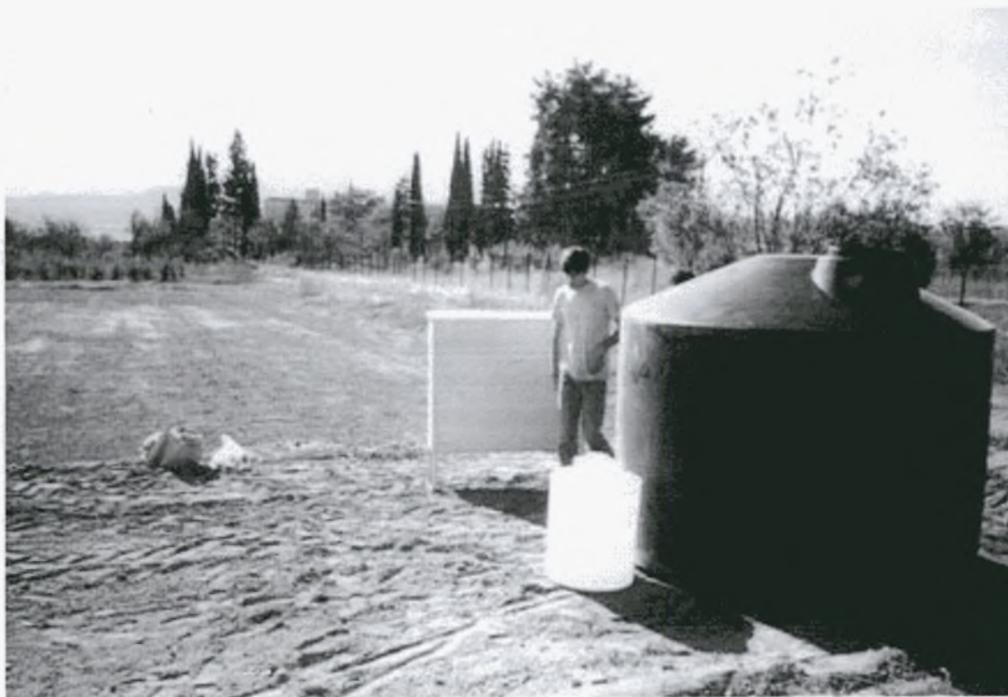
Εικόνα 2.2 Τοποθέτηση της πλαστικής δεξαμενής
