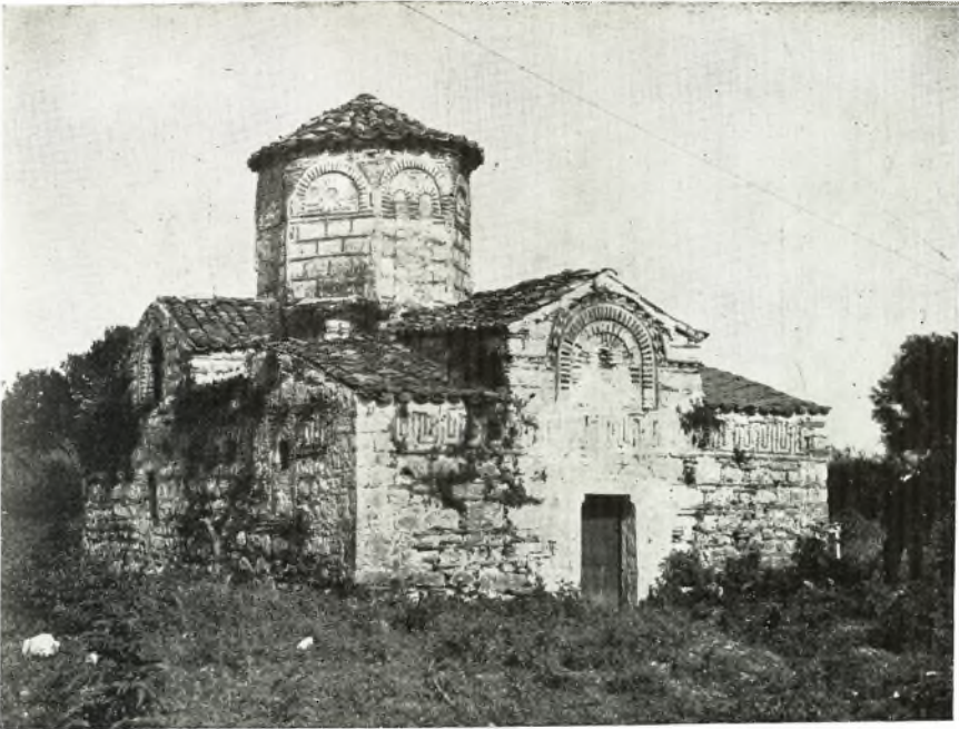
α. Ὁ Ἅγ. Νικόλαος τῆς Ροδιᾶς πρὸ τῶν ἐργασιῶν ἀναστηλώσεως. Ὅψις ἀπὸ ΒΔ.
