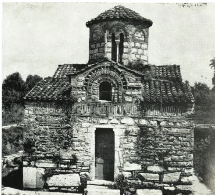
α. Ἡ δυτική πλευρά τοῦ Ἁγ. Νικολάου τῆς Ροδιάς μετὰ τὰς ἐργασίας ἀναστήλωσεως.
