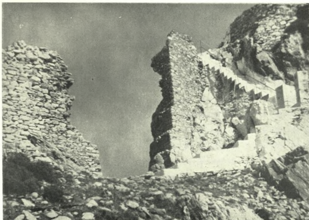
Σκίαθος, Κάστρον: α. Ἄποψις, β. Ἡ κατεστραμμένη γέφυρα
