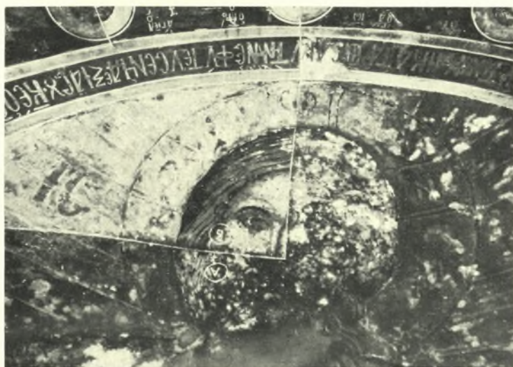
Θεσσαλία. Μετέωρα. Μονή Μεταμορφώσεως: α. Ἡ στέγη τοῦ Καθολικοῦ μετὰ τὴν ἐπισκευήν, β. Ὁ Παντοκράτωρ κατὰ τὴν διάρκειαν τοῦ καθαρισμοῦ
