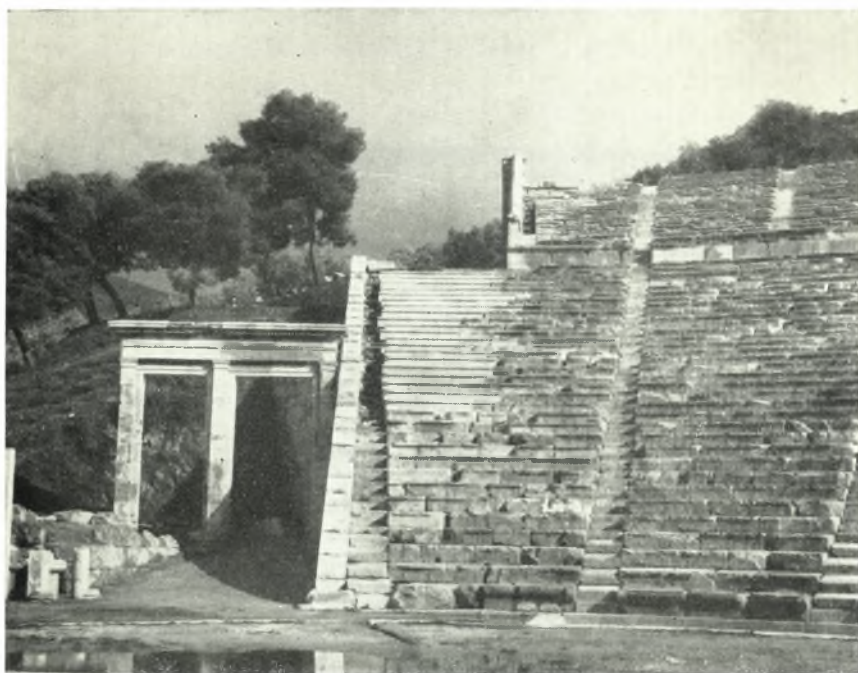
β. Ἐπιπέδου τοῦ βορείου ἡμίσεος τοῦ θεάτρου τῆς ἐπιδαύρου μετὰ τὴν ἀναστήλωση τοῦ ἀναλήμματος τοῦ ἄνω διαζώματος καὶ τοῦ βορείου θυρώματος.
