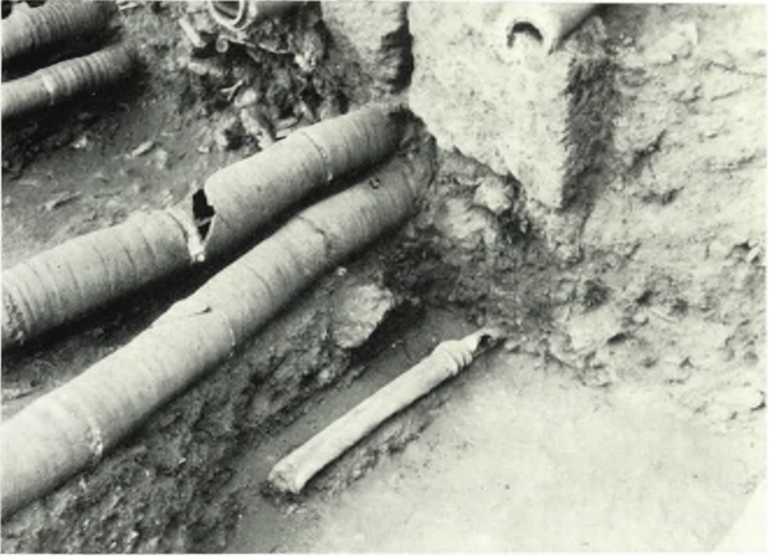
α. Οίκ. Πλατῆ. Μολύβδινος σωλὴν ὑπὸ τοὺς πηλίνους ἀγωγούς τῆς ὁδοῦ P17.
