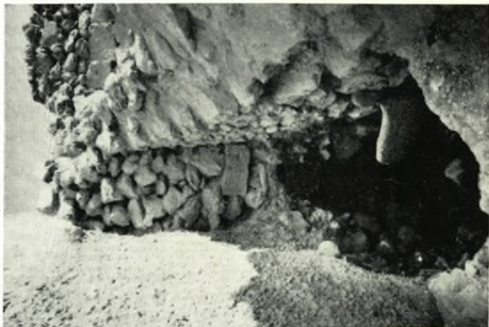
β. Δυτικός τοίχος τῆς συνοικίας Γ ἐκ Νότου. Δεξιά ὁ παχὺς τοίχος μετὰ τοῦ προέχοντος ἄκμονος. Ἀριστερὰ τὸ στήλιμα τῆς κισήσεως, ὑφ' ἧ κρύπτεται ἡ συνοικία Δ. Ἄνω ὁ τοίχος τῶν τραγλοθυτῶν, προφανῶς πρὸς ἀπόφραξιν τῆς ὁδοῦ μεταξὺ τῶν συνοικιῶν Γ καὶ Δ.
